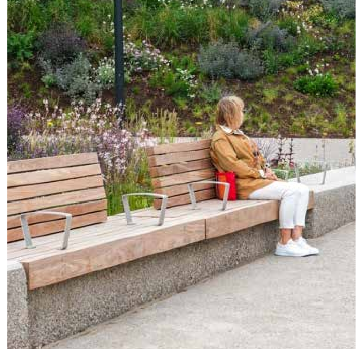
Figuur 30: Houten zitting op betonelement
